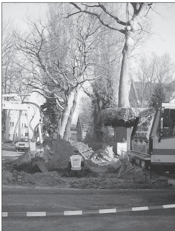
Het voorbereidende werk is begonnen. Foto: Ron Holdorp
