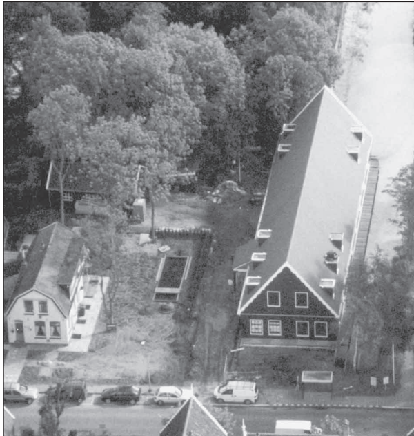
Het imposante pand vanuit de lucht gezien.
