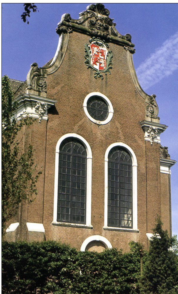
De gevel van de monumentale kerk met het wapen van Westzaan.
