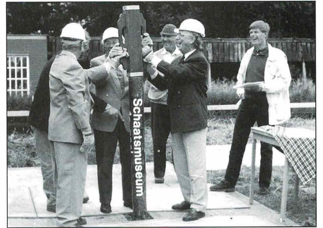
In 1996 werd de eerste paal geslagen, rechts architect Ard Berghouwer.
