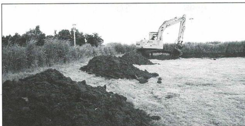
Duizenden kubieke meters grond werden verzet voor de goede balans in de polder Westzaan.
