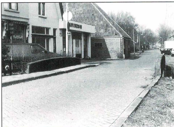
Hard aan vernieuwing toe...
