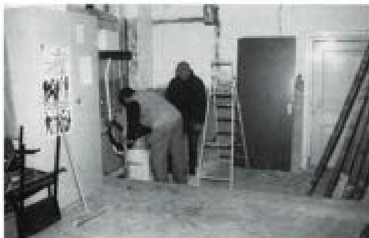
De tweede fase van de restauratie van het Recht Huys is in volle gang. 'Oprichter' Wim Kooijman houdt toezicht.
