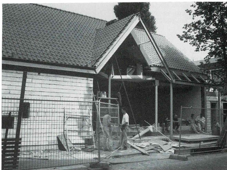
De bouw in een vergevorderd stadium
