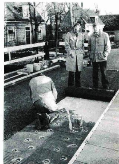
De tapijtlegger in actie
