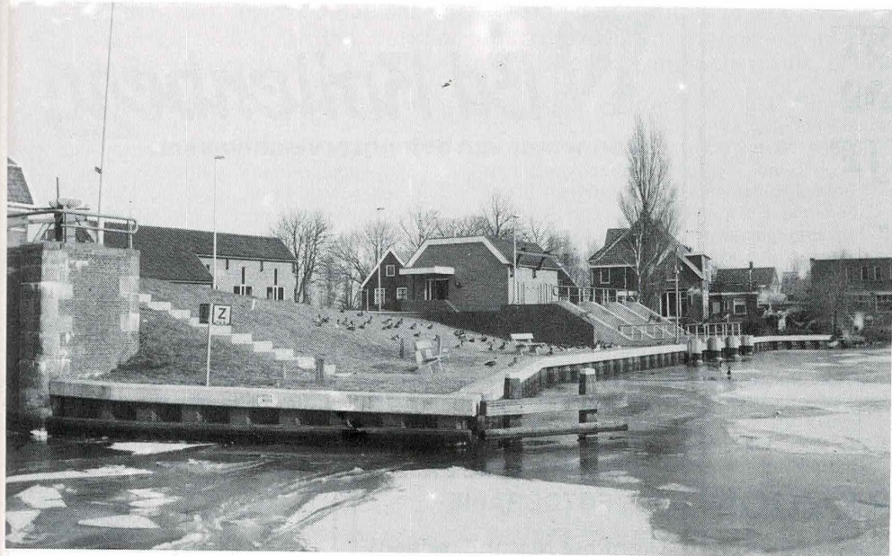
Het gemaal aan de Overtoom speelt een grote rol bij de waterhuishouding van Het Lange Rond
