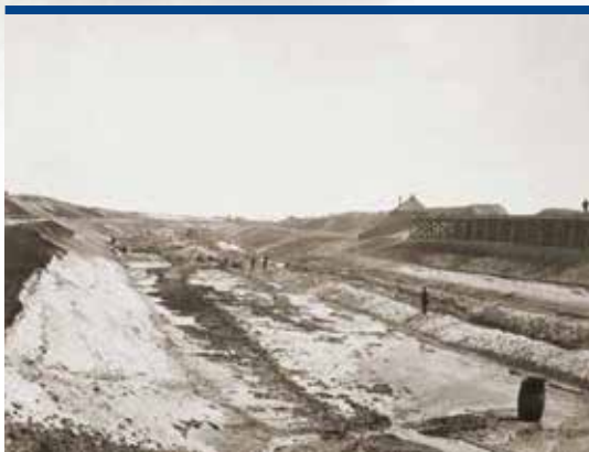
De aanleg van het Noordzeekanaal.
